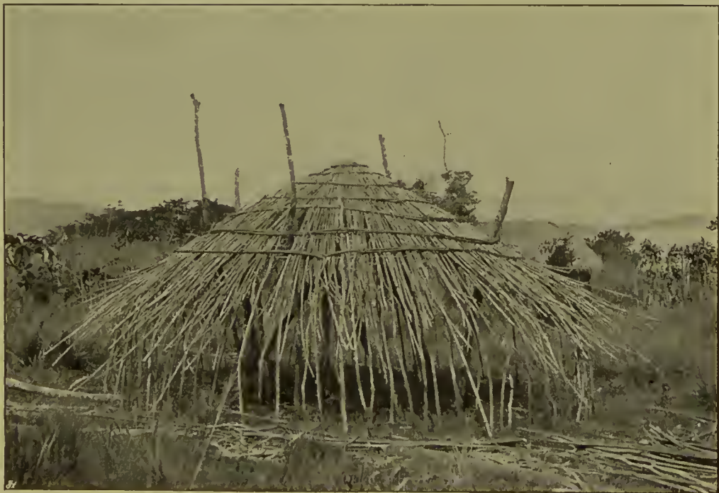
Fig. 97. Bau einer Rundhütte auf den Sese-Inseln.
